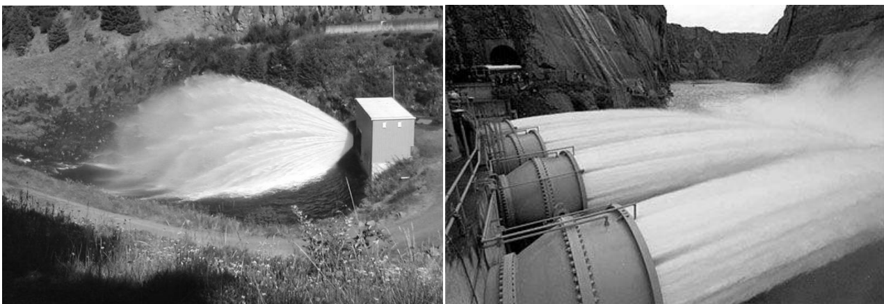
Figura 1.- Izquierda: Descarga libre de una válvula HB. Timothy Lake Dam, Arizona, E.E.U.U.. Derecha: Descarga con anillo concentrador. Glen Canyon Dam, Arizona, E.E.U.U..
